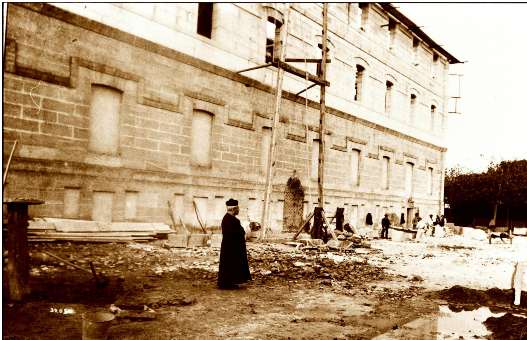
Le Séminaire Saint Firmin en construction – années 1870 -Montpellier
